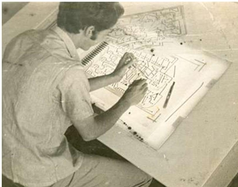
Figura 2.3. Dibujando una máscara con *tape* sobre acetato. A la izquierda del acetato puede verse el *tape* depositado en líneas paralelas, donde quedarán las delgas de la tarjeta.
